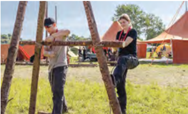
Der bygges indgangsportal.
