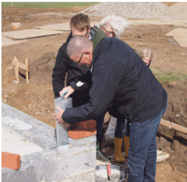
Kjeld Kjeldsen, kirkeværgen siden 1997, satte til sidst en tidskapsel på plads bag grundstenen. Det er planen, at der senere indsættes en glassten i murværket, så tidskapslen bliver synlig.
